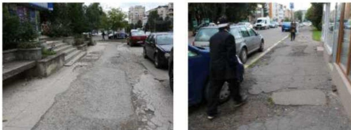
**Figura 2.106.** Trotuare în stare necorespunzătoare (exemplificare).
